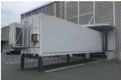
40フィート冷凍コンテナ ドックシェルター接続
