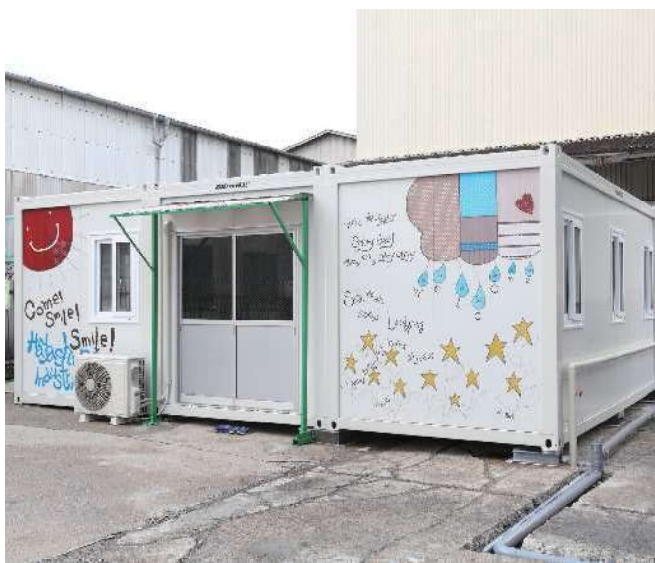
接続設置例(外観)
