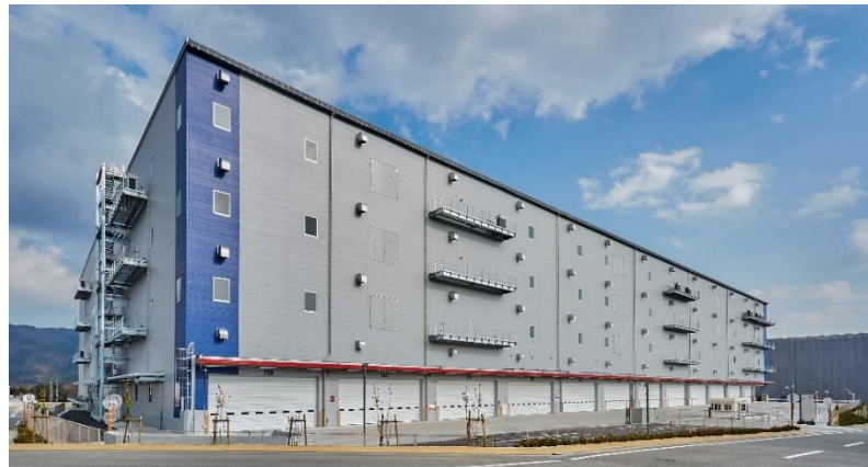
箕面ロジスティクスセンター（2022年3月竣工）
